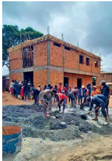
Construction du dispensaire.
